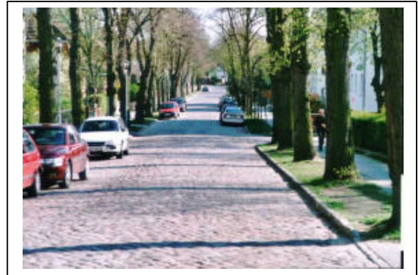
Die neugestaltete Bahnstraße
