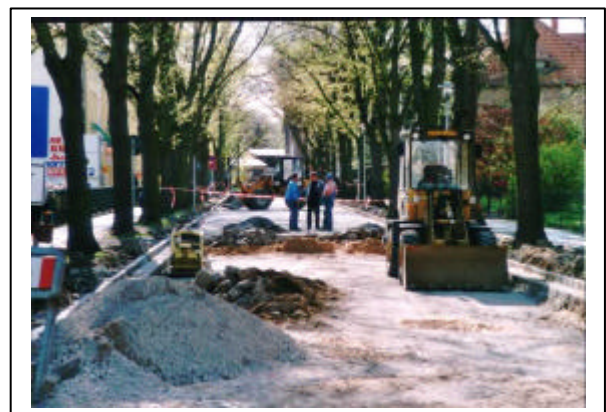
Albertstraße im Bau
