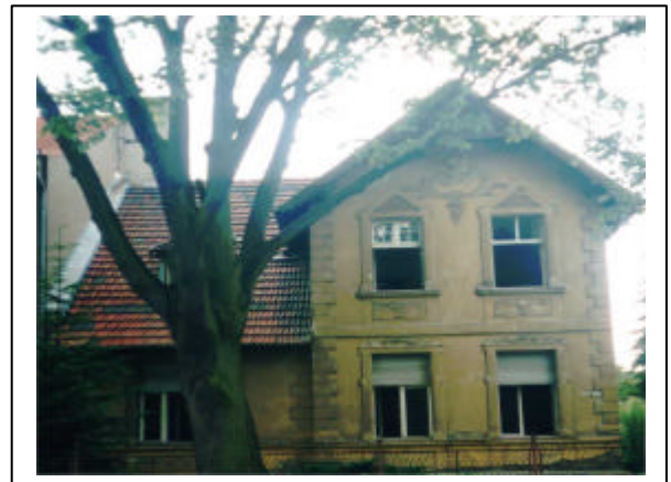
Der originale Zustand ist gute Basis für die Sanierung
