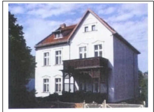
Vorbildhafte Rekonstruktion - Friedrichstraße 16
